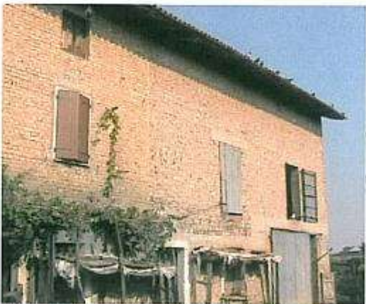
Unità di rilevamento 7
