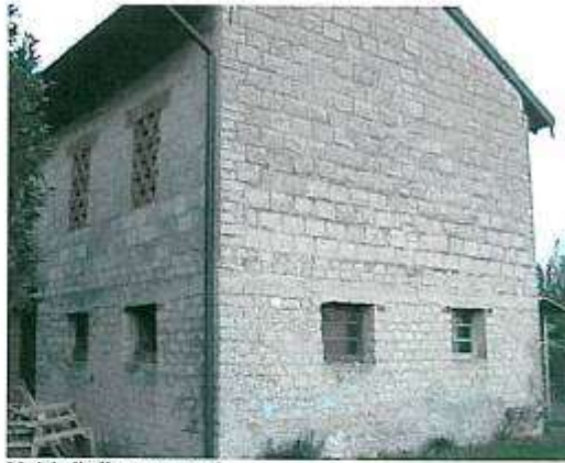
Unità di rilevamento 4
